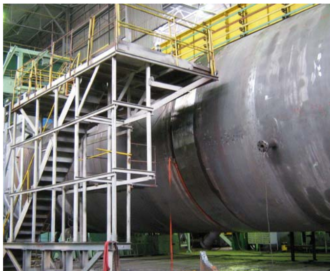
Рис. 9. Общий вид помоста, с которого выполнялась установка трека и сканера
