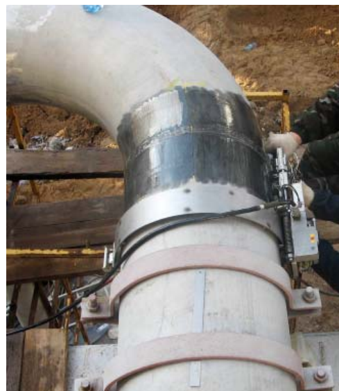
Рис. 8. Проведение АУЗК аустенитных сварных соединений
