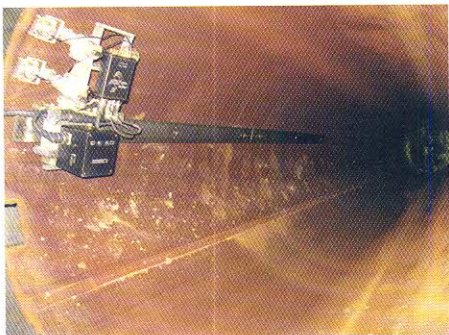
Рис. 6. Проведение АУЗК со стороны внутренней поверхности
