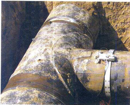
Рис. 10. Проведение АУЗК внутреннего сварного соединения «патрубок–обечайка»
