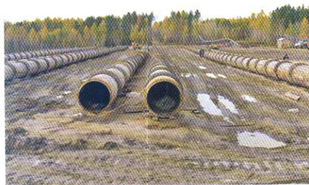
Рис. 8. Плеты труб для подводного перехода
