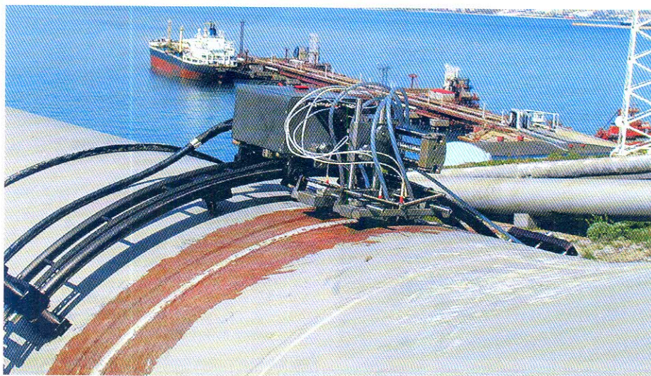
Рис. 13. Контроль нефтепровода системой «Авгур»
