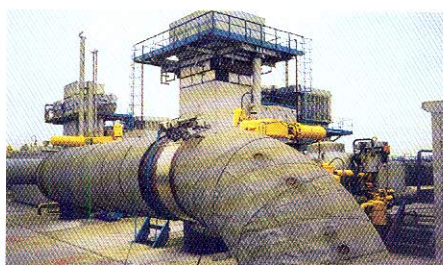
Рис. 11. Контроль системой «Авгур» трубопровода Ду 1200 на ГКС
