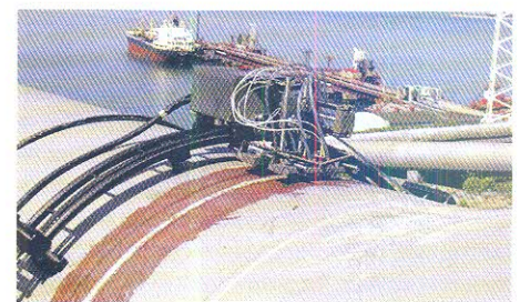
Рис. 3. Контроль нефтепровода с использованием системы «Авгур»
